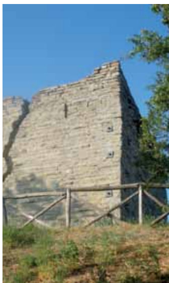
Dernice (AL), i resti della torre del castello.
