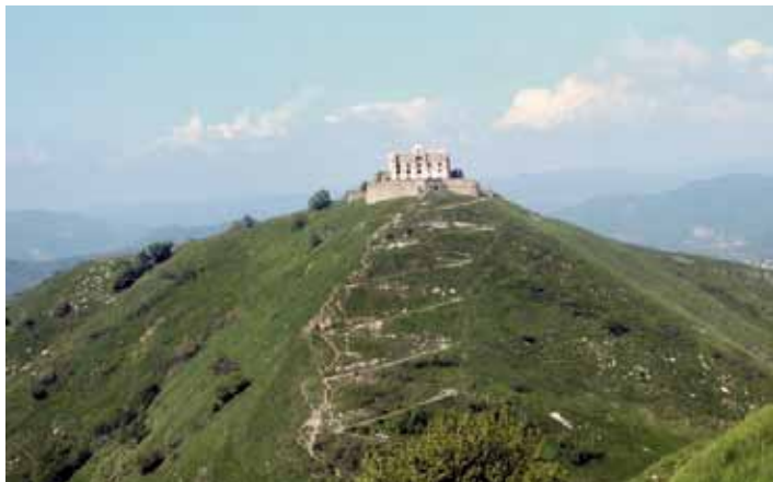
La salita conclusiva che conduce al Forte Diamante, sulla vetta del Trensasco.
