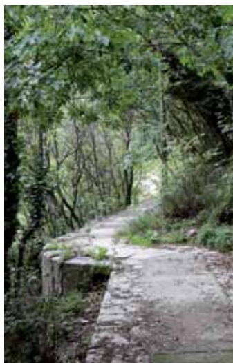
Il tratto dell'acquedotto seicentesco poco prima di giungere alla presa sul Trensasco, immerso in un paesaggio dai sapori romantici.
