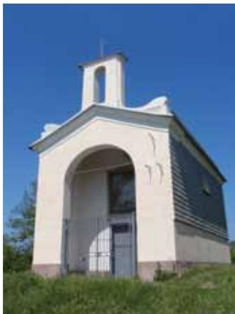
*Cappella di Monte San Giacomo con il rivestimento in lastre d'ardesia realizzato per preservare il muro dai danni causati dalle intemperie.*
